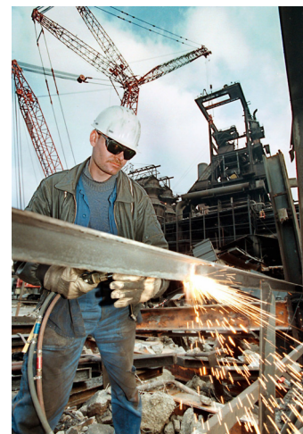
Abb. 17: Schweißarbeiten im Stahlwerk
